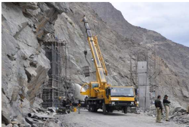
Baustelle am KKH zur Entschärfung von Gefahrenstellen
